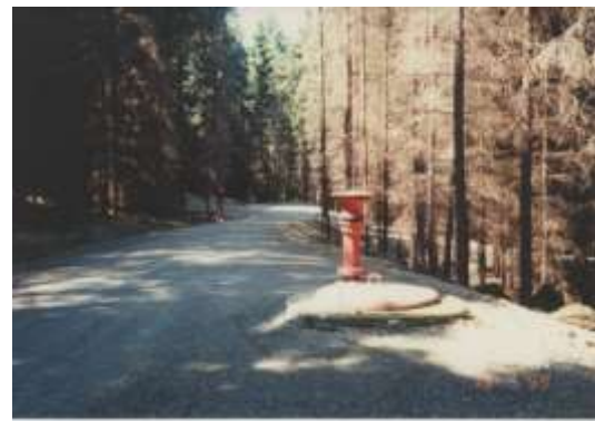
Nově vybudovaná komunikace ke studnám - foto z r. 1999
