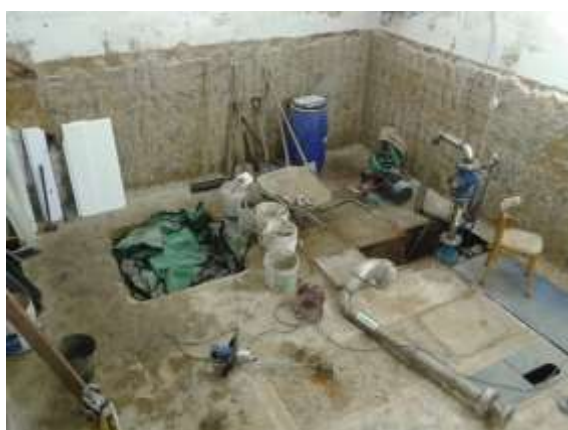
Interiér při rekonstrukci
