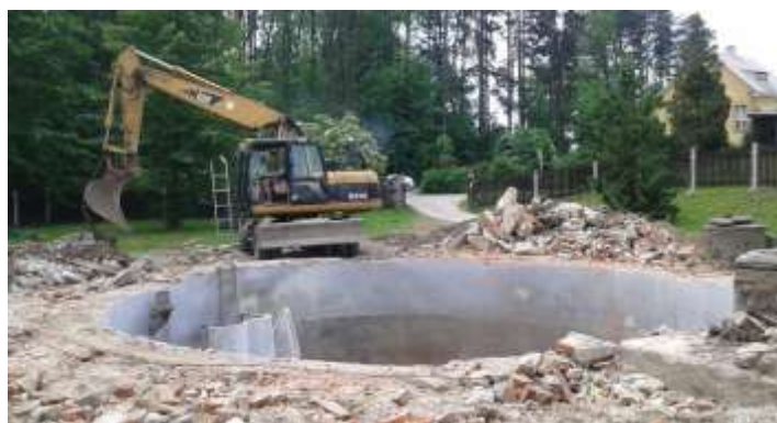
Demolice původní stropní desky
