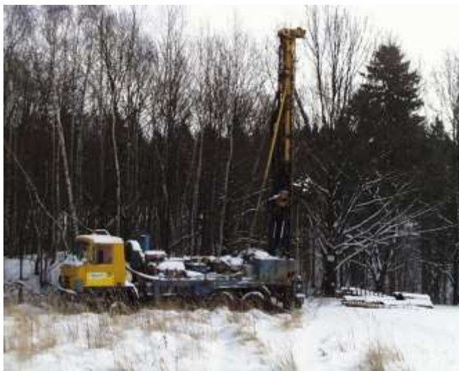
Těžké podmínky při výstavbě monitorovacího systému jímacího území v roce 2005
