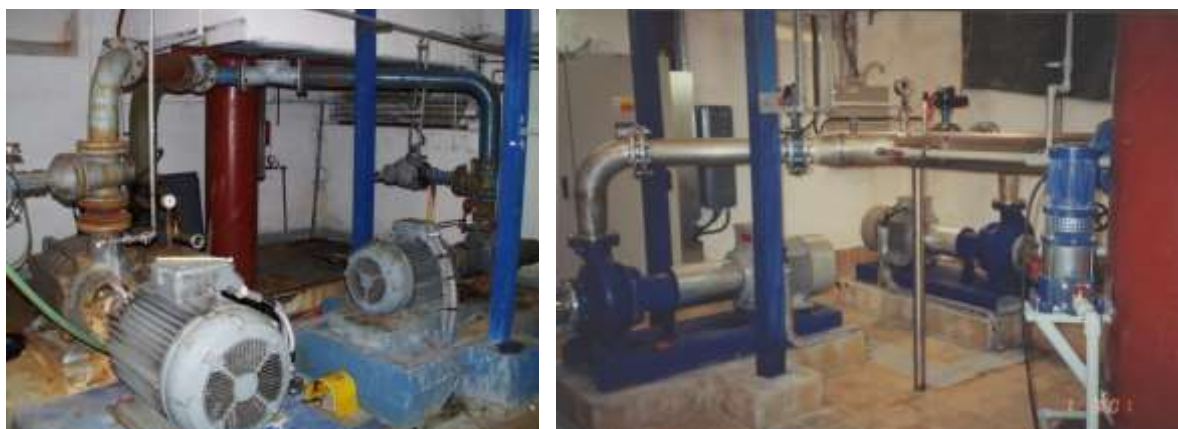
Stav ČS před a po rekonstrukci
