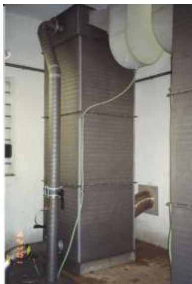
Instalace aeračních věží – foto z r 2001
