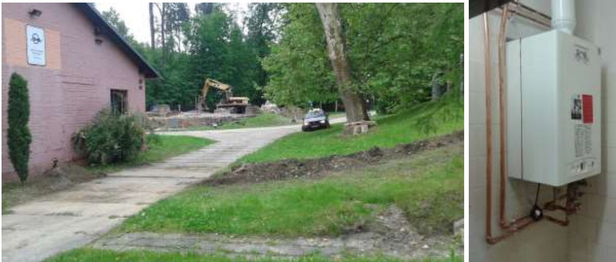
Nová plynovodní přípojka (v pozadí demolice stropní desky sběrné studny) + nový plynový kotel
