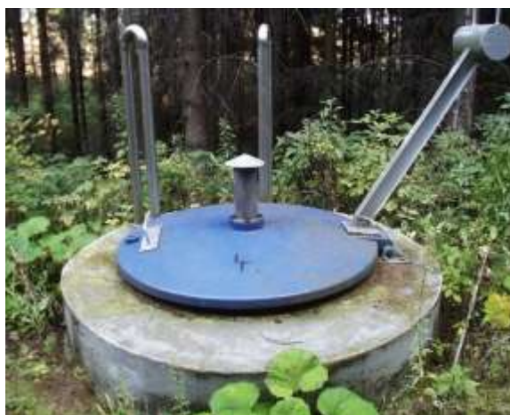
Studna IV - stav v r. 2004
