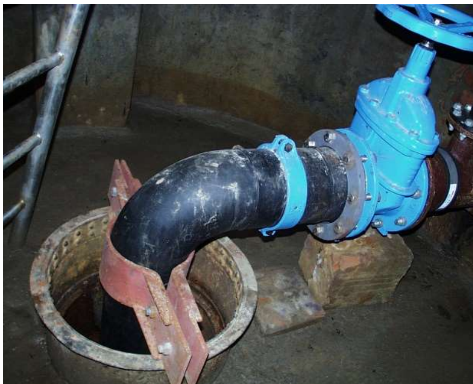
Interiér studny X po výměně potrubí 2004 s původní výstrojí studny z prvních let 20. stol.
