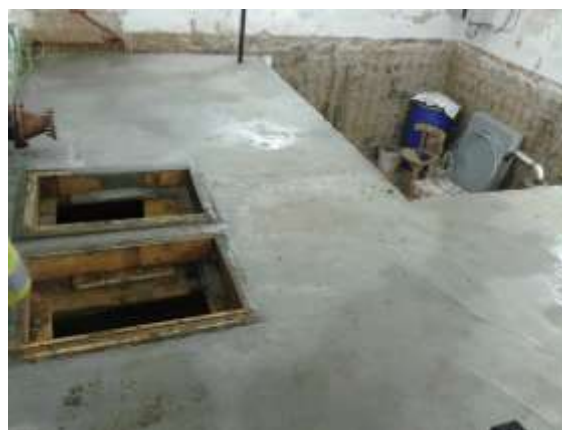
Výstavba vodojemu uvnitř budovy
