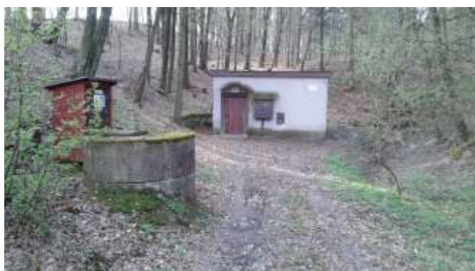
Studna 2 s čerpací stanicí v roce 2015
