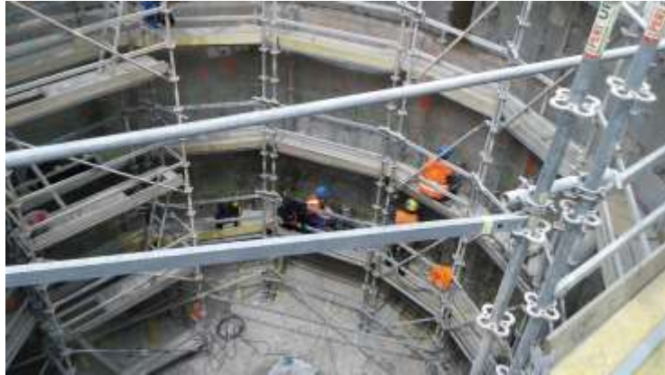
Injektáže sběrné studny
