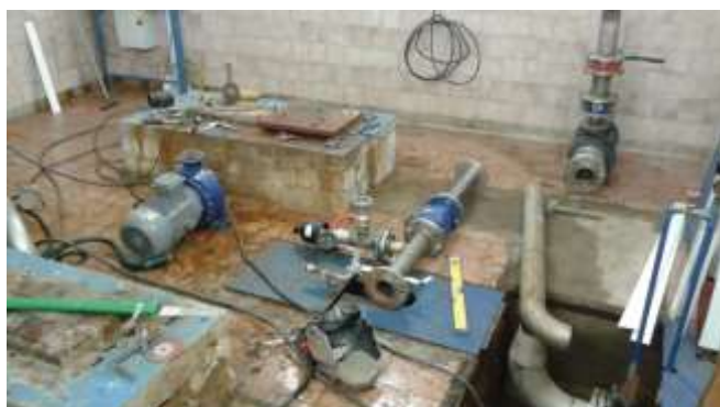
Demontáže technologického vybavení
