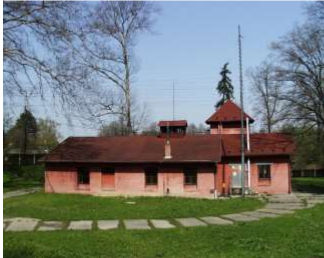
Budova čerpací stanice v roce 2006
