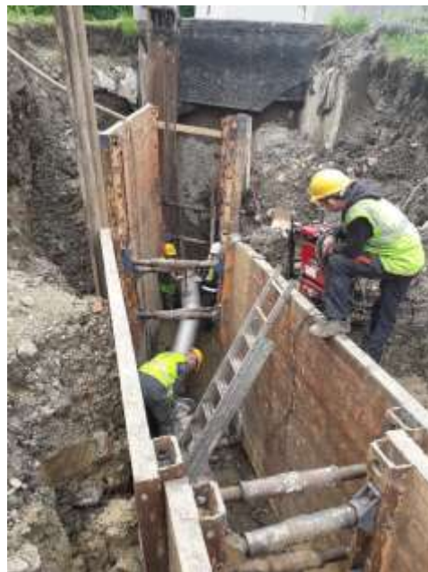
Výměna potrubí mezi sběrnou studnou a budovou čerpací stanice
