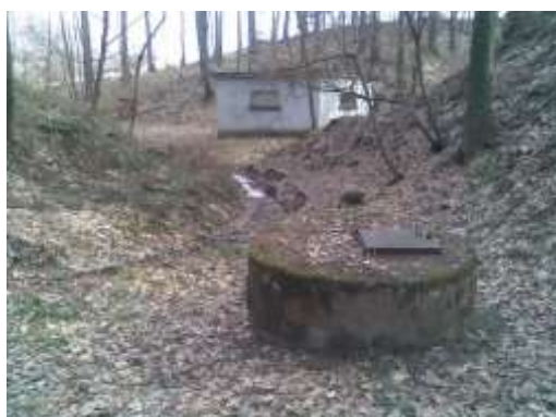
Studna 3 s čerpací stanicí v r.2012
