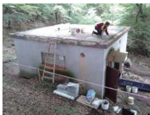
Úpravy budovy čerpací stanice
