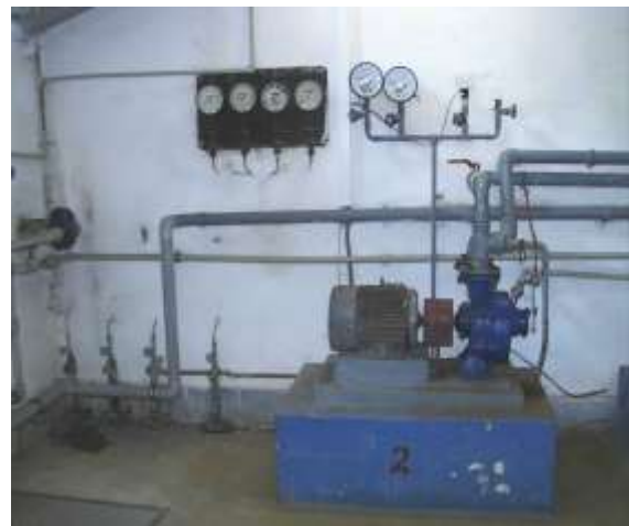
Vývěva napojená na násoskový systém - foto z roku 2004
