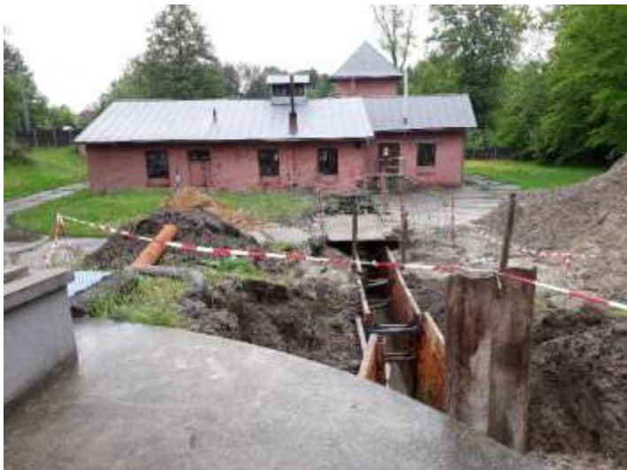
Výměna potrubí mezi sběrnou studnou a budovou čerpací stanice
