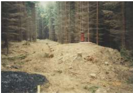
Příprava na vybudování komunikací ke studnám – foto z r. 1988
