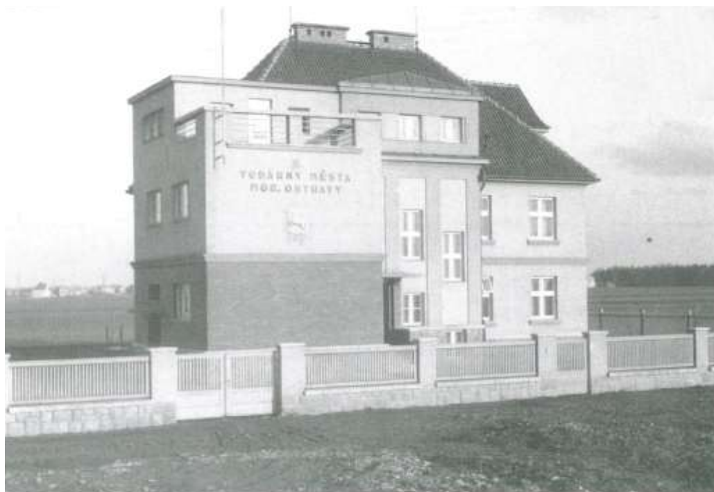
Budova velínu ve 30. letech 20. stol.
