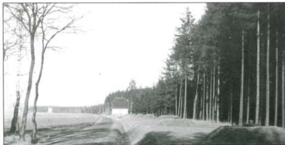
Pohled na studny I. jímacího řadu vč. čerpací stanice 1 po ukončení výstavby v 30. letech (Po levé straně se dnes nalézá Koliba, v pozadí panelové domy u smyčky tramvají č. 11 a 13.)
