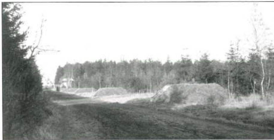
Pohled na studny III. jímacího řadu (V okolí studen dnes stojí objekty bývalého vojenského útvaru a Tatry. Nalevo od budovy v pozadí se dnes nachází hřiště minigolfu.)
