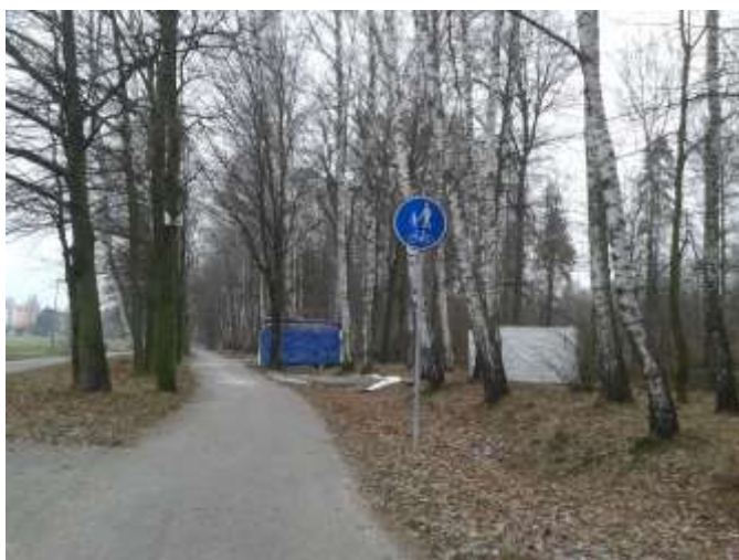
Pohled na staveniště
