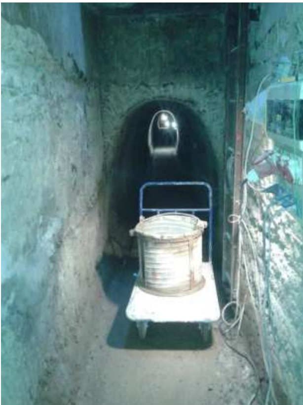
Doprava materiálu štolou
