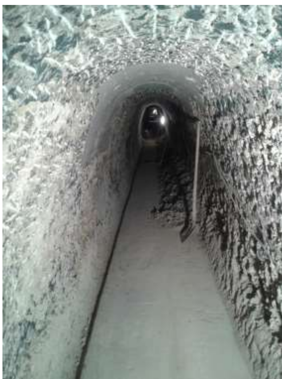
Osekání nesoudržných vrstev
