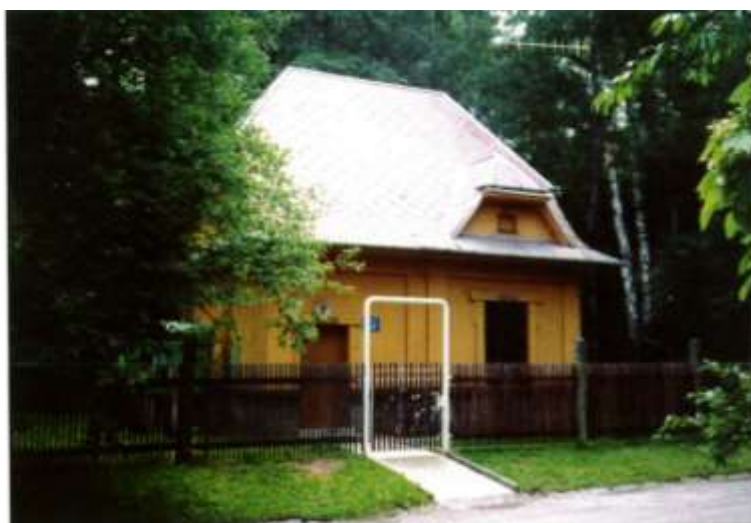
Budova ČS 3 v 90. letech 20. stol.
