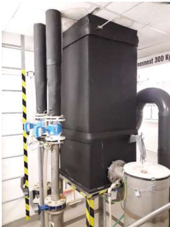
Izolace aerační věže na čerpací stanici 3
