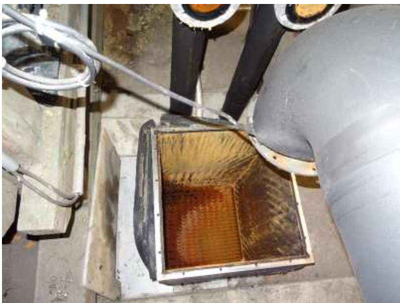
Pohled do aerační věže č. 2 shora před čištěním od nánosů vysráženého železa
