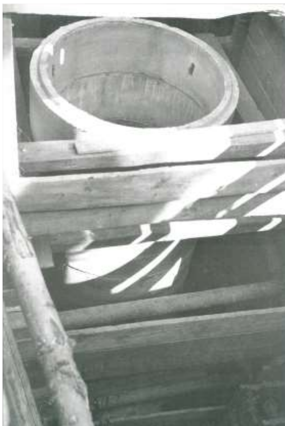
Výstavba studen v lokalitě „Studně“ poč. 30. let 20. stol.
