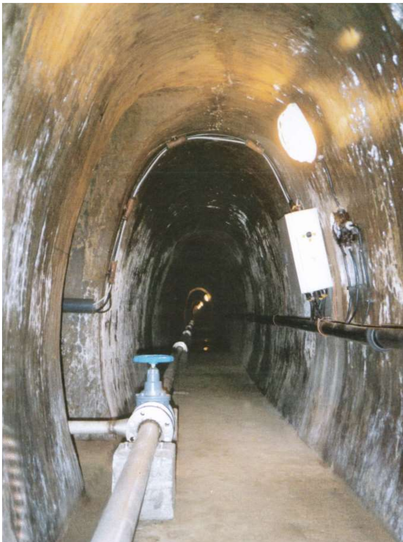
Štola jímacího řadu 1 před generální opravou, tj. před r. 2016
