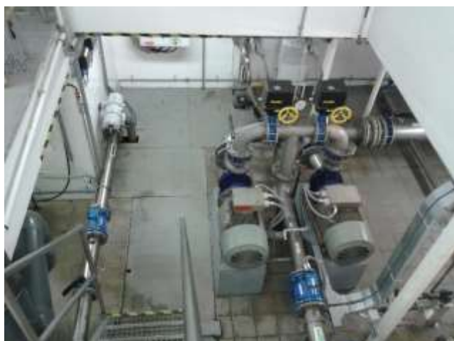
Interiér čerpací stanice 3
