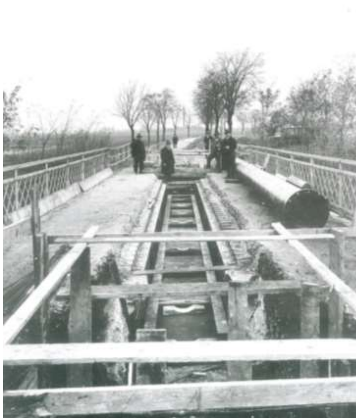
Kladení potrubí do mostu na Výškovické ulici přes tzv. Polaneckou spojku
