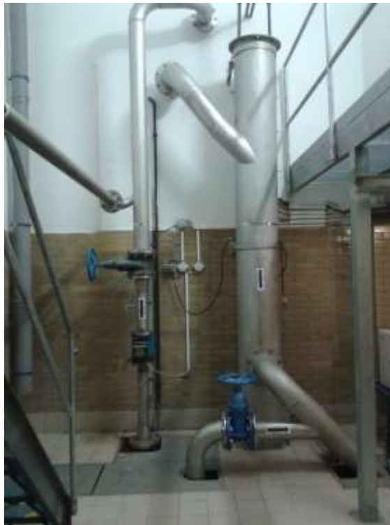
Interiér čerpací stanice 2
