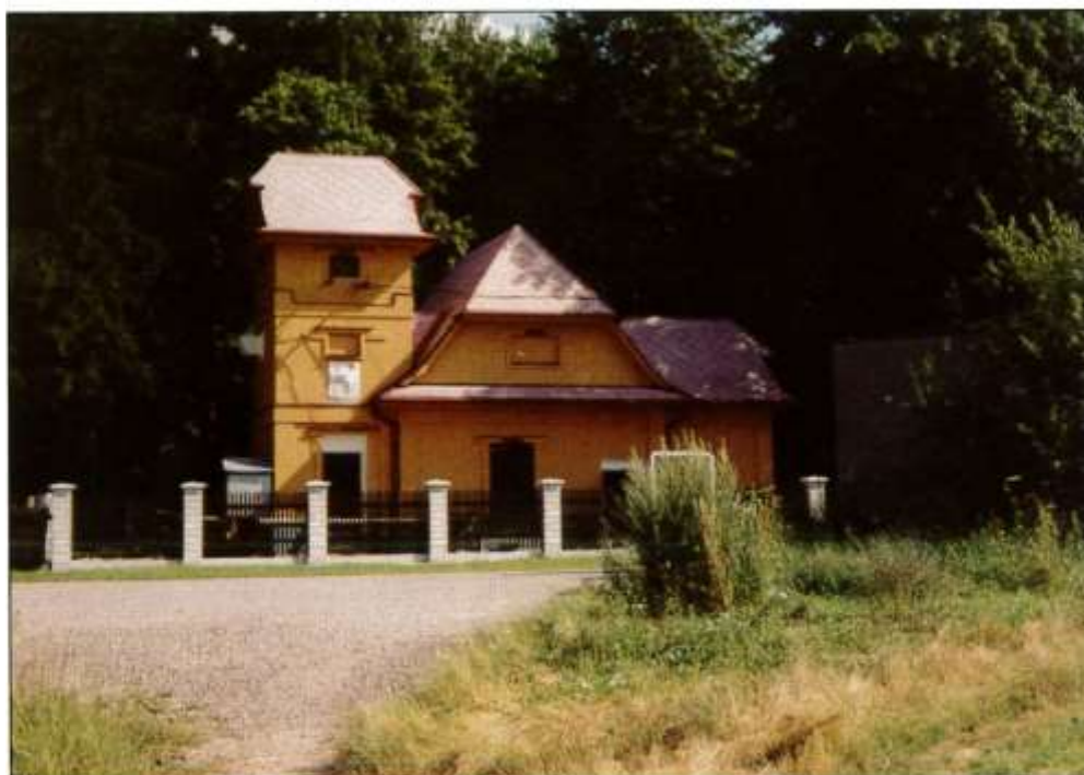
Budova ČS 2 v 90. letech 20. stol.
