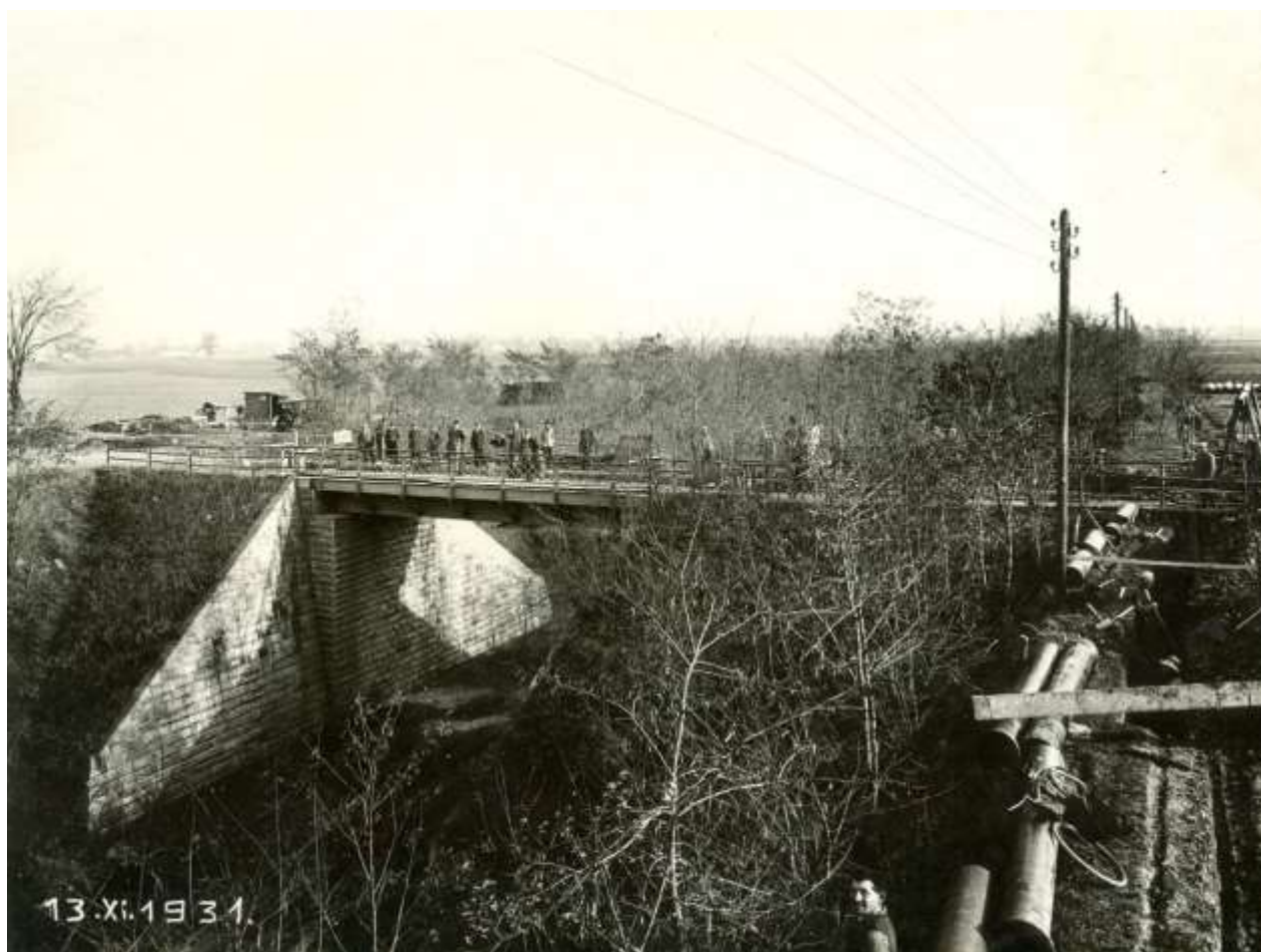
1931 – Kladení potrubí DN 350 z velínu na Korýtko
