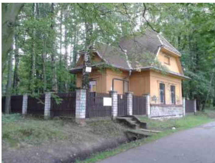
Budova čerpací stanice 1
