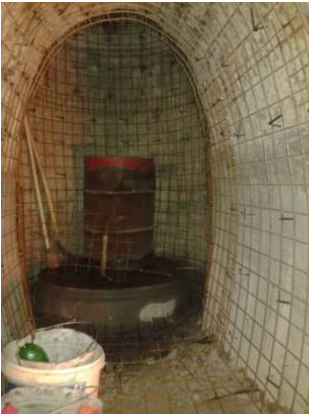
Armování před torkretáží
