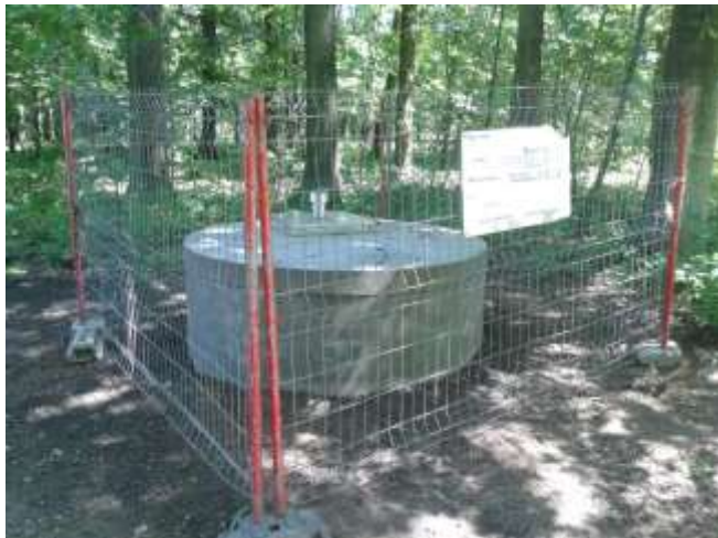
Studna z vnějšku těsně před dokončením
