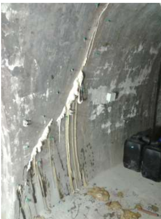
Sanace trhlin a injektáže
