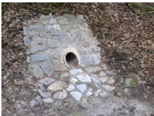
Opravený výustní objekt
